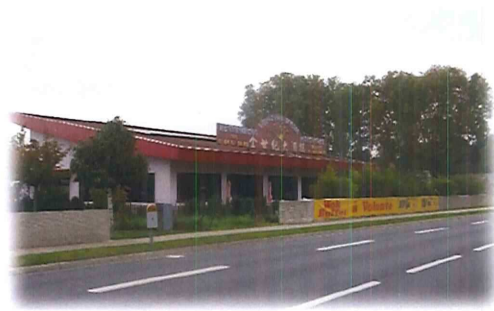
Enseignes sur toiture non réalisées en lettres ou signes découpés.
