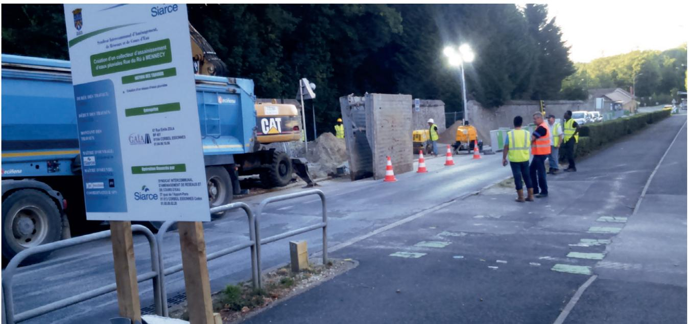
Afin d'améliorer l'écoulement des eaux pluviales lors de fortes pluies et s'affranchir d'un réseau vétuste qui transitait sous des parcelles privées, un réseau d'eaux pluviales de diamètre 400 mm a été créé rue du Rû à Mennecy sur 250ml. Ce réseau a été raccordé au réseau existant avenue de Villeroi. L'avenue étant une voirie départementale, les travaux de raccordement ont été réalisés de nuit.
