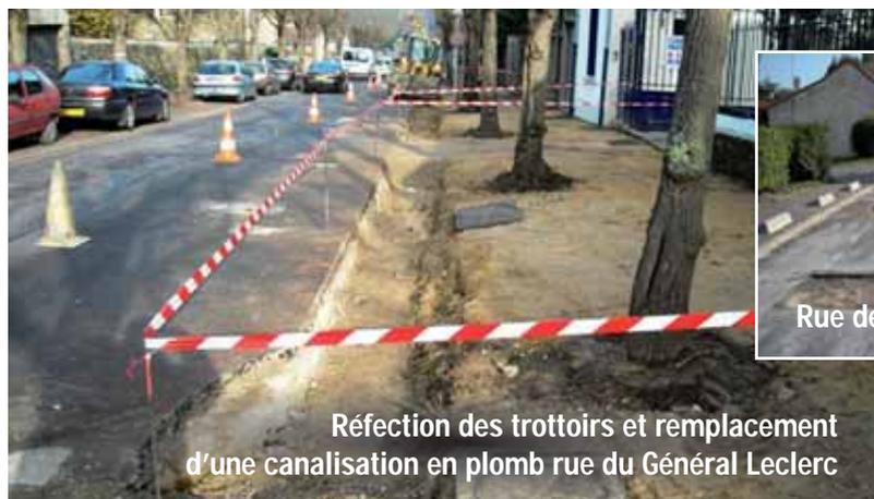
Réfection des trottoirs et remplacement d'une canalisation en plomb rue du Général Leclerc
