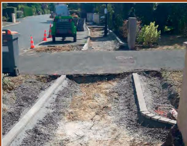
Compte tenu de la dégradation des trottoirs, due aux racines des arbres les bordant, et en accord avec l'AFUL du Domaine de Mennecey qui a pris en charge leur abattage, la réfection des trottoirs a pu être réalisée.
