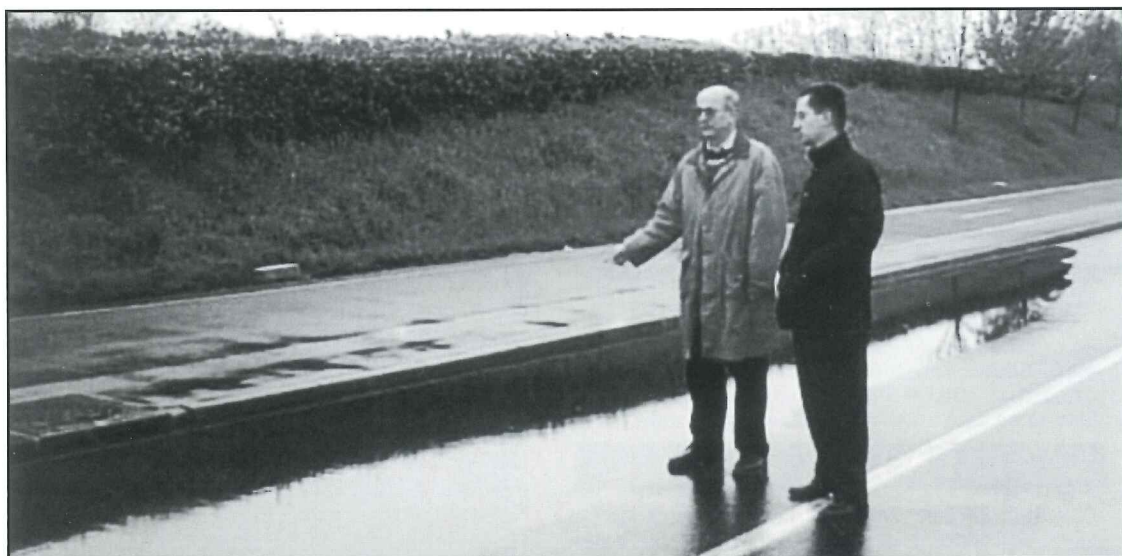
Constat en date du 13 avril 2001 des inondations sur la Route Départementale n° 153 par Monsieur Patrick IMBERT du Conseil Général du Canton de Menncy et par Monsieur Daniel PERRET, Maire Adjoint de Menncy, chargé de la voirie
