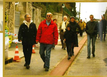
25 MARS : Point sur l'avancement des chantiers en cours avec les élus, les responsables des services concernés et les entreprises.
